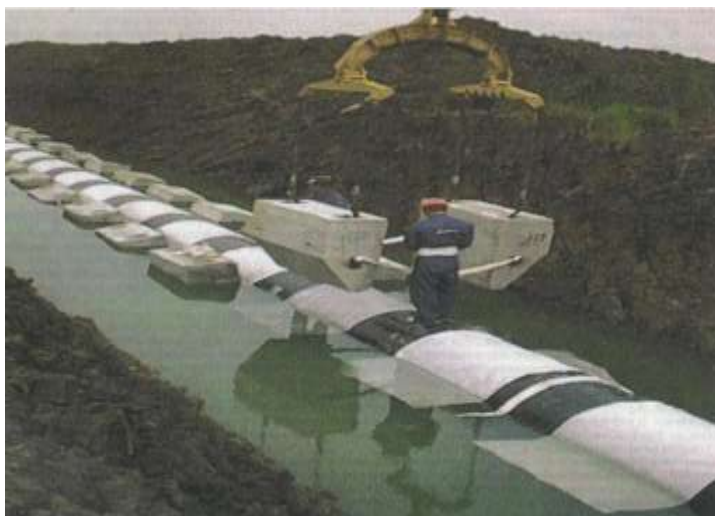
Рисунок 4. Установка железобетонных пригрузов типа УБО
