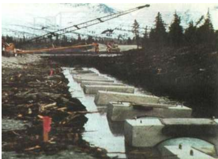
Рисунок 5. Балластировка одиночными железобетонными седловидными пригрузами
