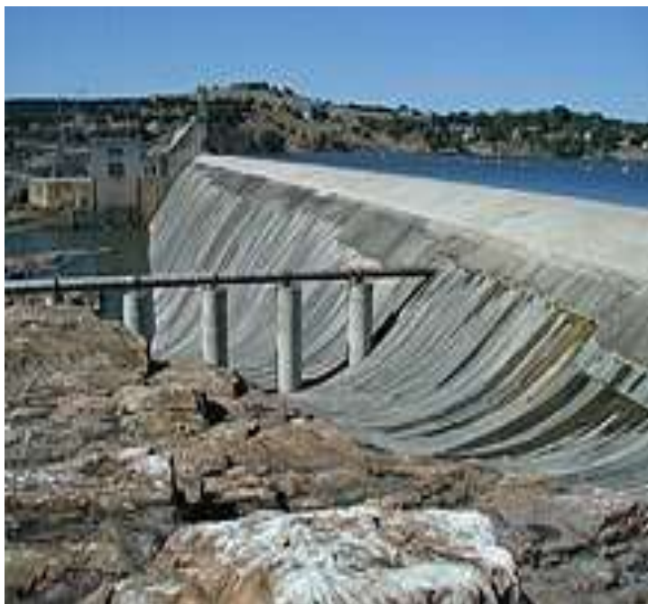
Надземная прокладка трубопровода через канал. Опоры в виде железобетонных колонн.
