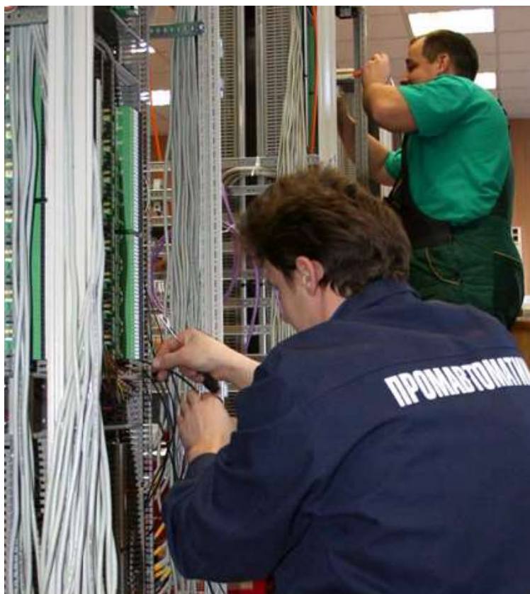
Монтаж АСУ ТП на предприятии нефтегазового комплекса
