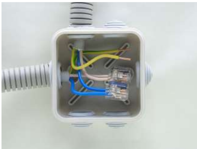
Применение клемм WAGO в соединительной коробке
