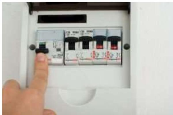
Рис.1. Отключение электроустановки
