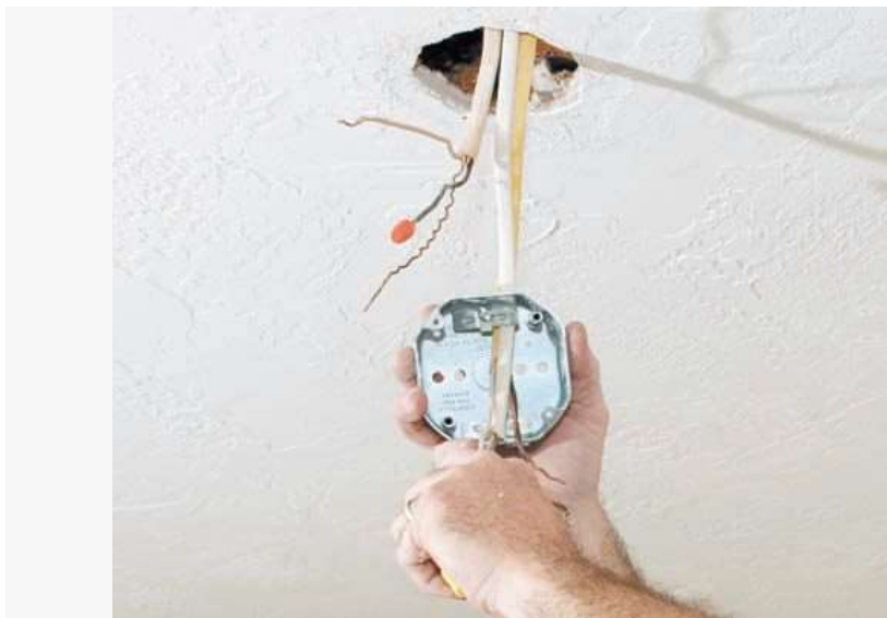
Монтаж коробки крепления под люстру в гипсокартонном потолке
