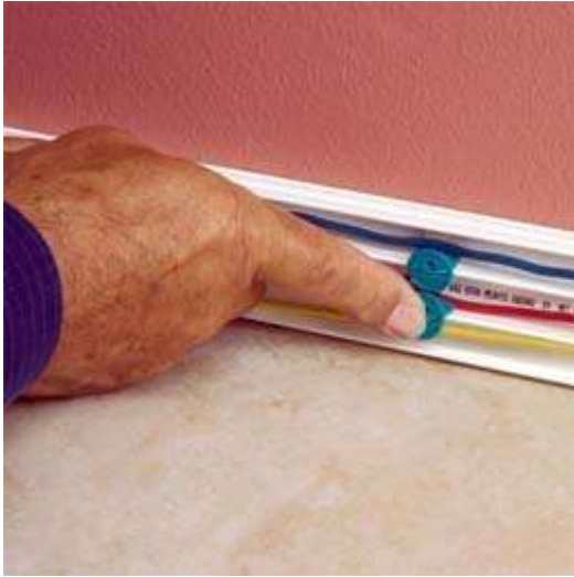
держатели проводов в кабель- канале разделение силовых и слаботочных каб
