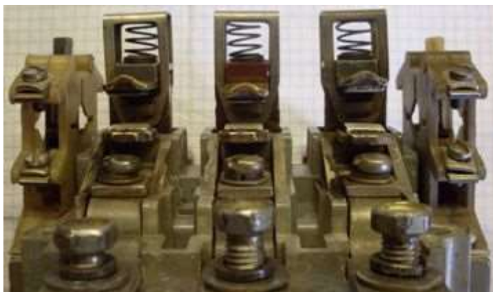
Ремонт выводных зажимов магнитных пускателей
