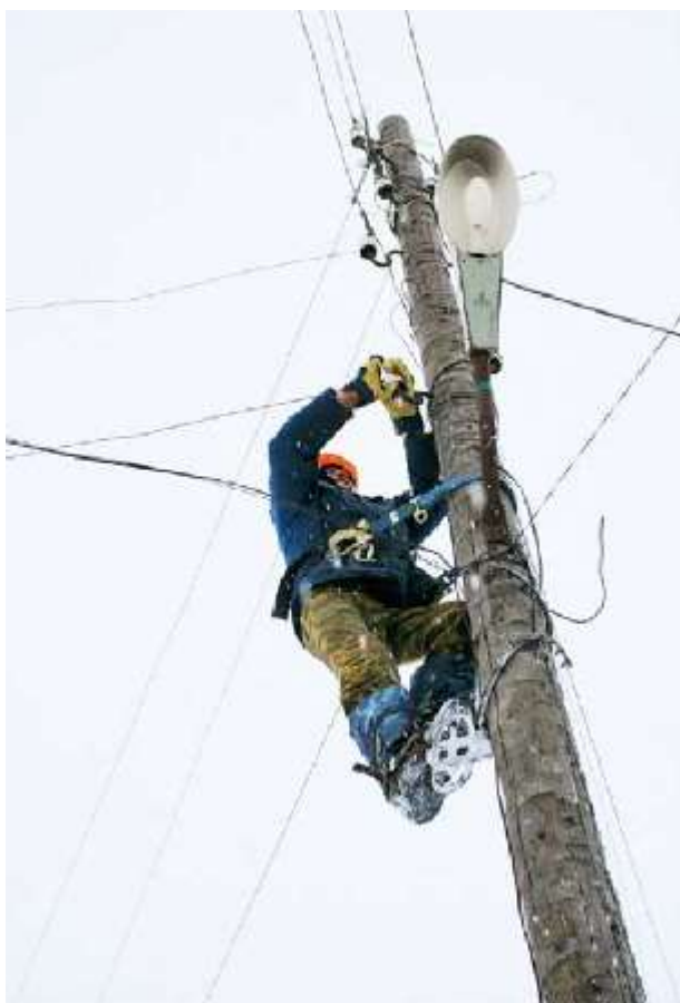
Очистка трассы воздушной линии
