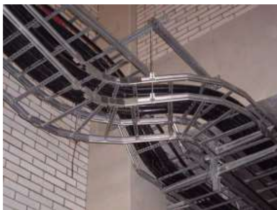
Прокладка кабеля в лотках
