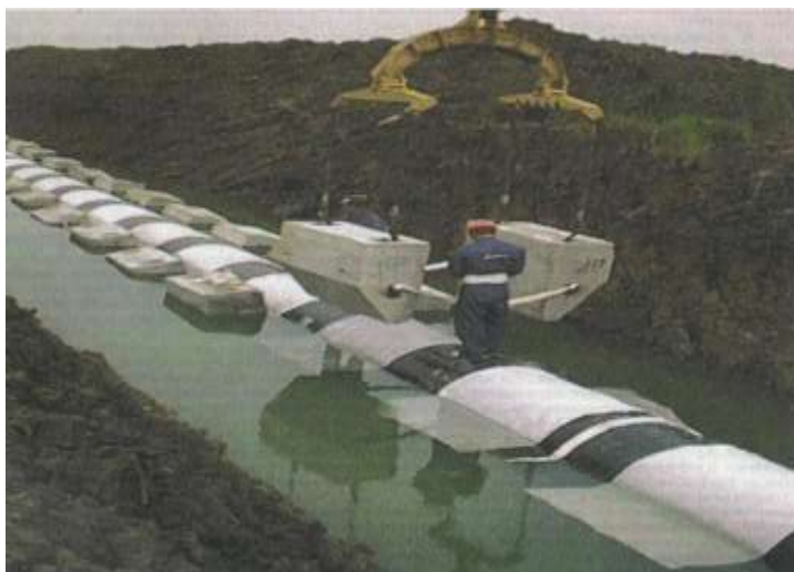
Рисунок 4. Установка железобетонных пригрузов типа УБО
