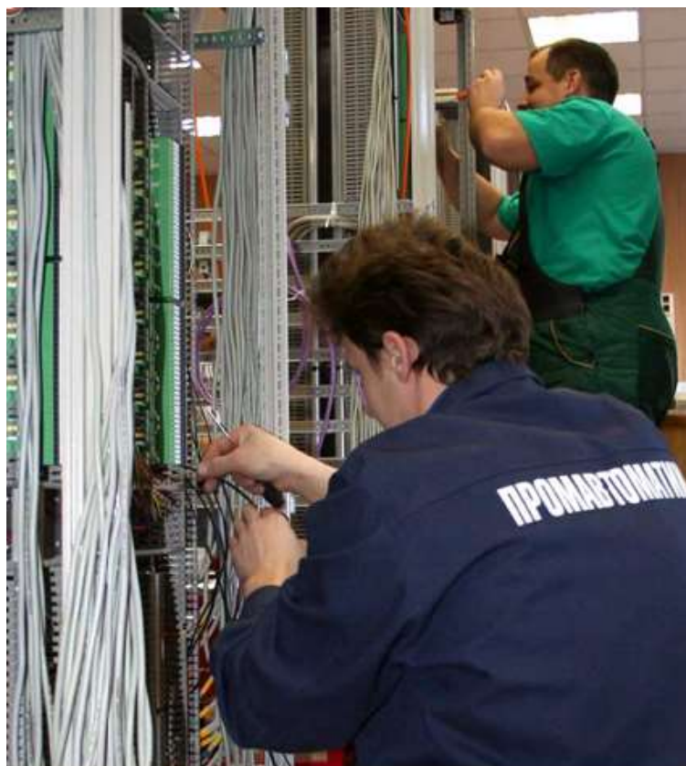
Монтаж АСУ ТП на предприятии нефтегазового комплекса
